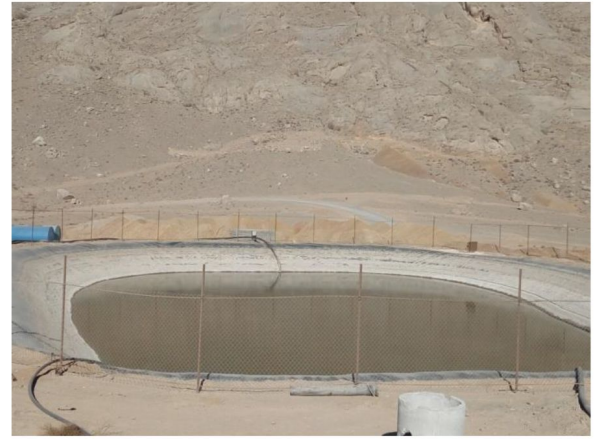
اجرای مخازن ذخیره و بازگشت آب
